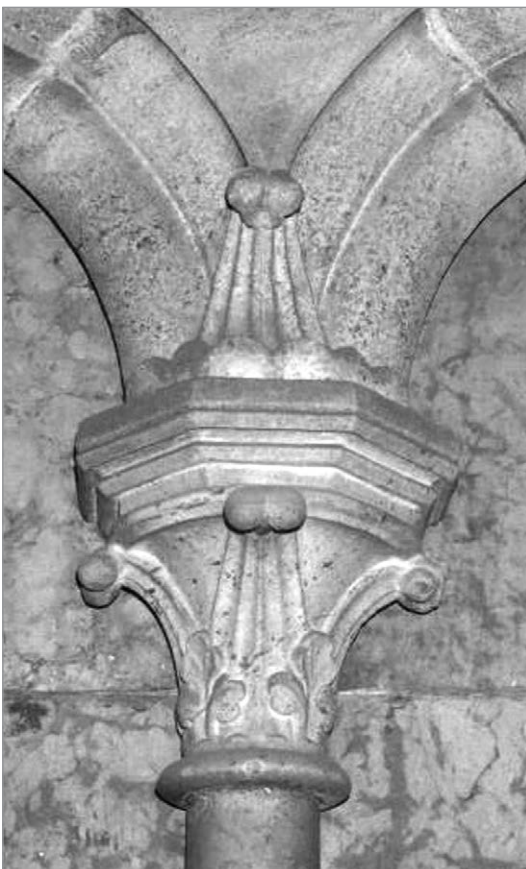
Abb. 34: Laxenburg, Franzensburg: Vorhalle der Burgkapelle. Linke Seitenwand. Kapitell V13 der wiederverwendeten Blendarkatur aus der Capella Speciosa.
